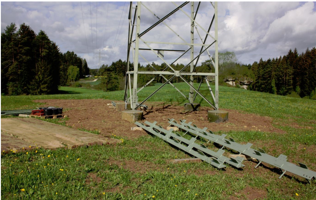
Abbildung 18: Mastverstärkungsteile mit Arbeitsfläche
