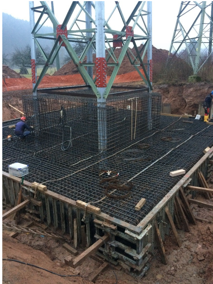
Abbildung 17: Beispiel für Fundamentarbeiten (Plattenfundament) , Schalung und Bewehrungsstahl
