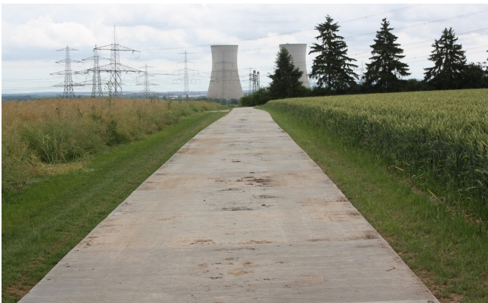
Abbildung 10: Zuwegung über Aluplatten (schwerer Wegebau)
