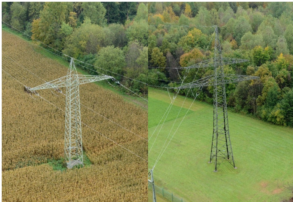
Abbildung 6: Einebenenmast und Donaumast
