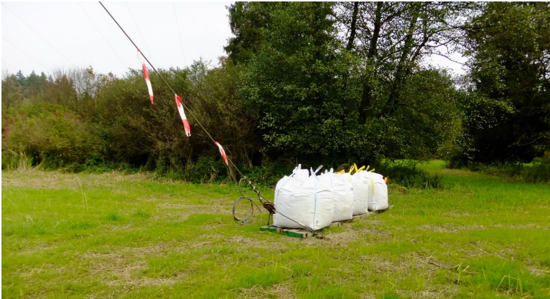
Abbildung 16: Abankerung mittels Ballastschlitten
