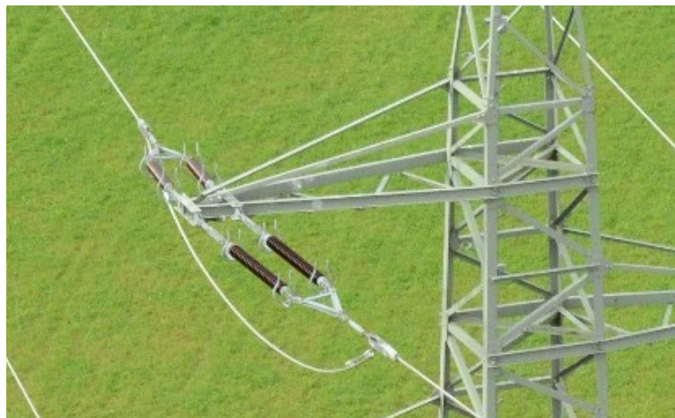
Abbildung 9: Abspannketten
