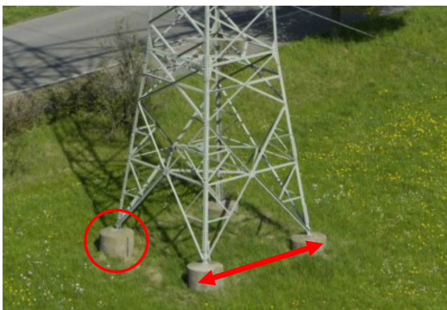
Abbildung 3: Sichtbare Fundamentköpfe und Bodenaustrittsmaß
