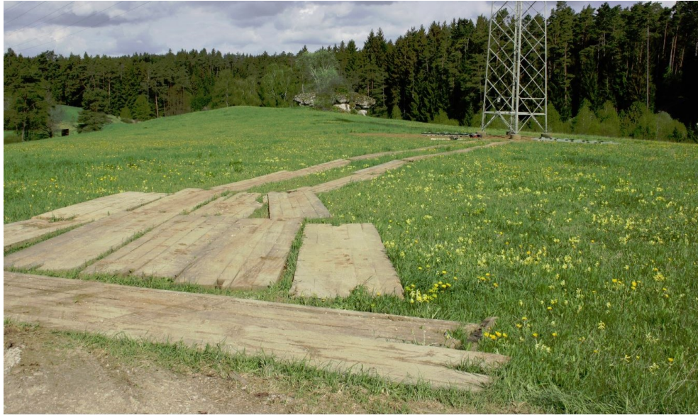
Abbildung 11: Zuwegung über Holzplatten (leichter Wegebau)
