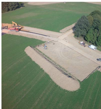
Zu sehen ist der Bauablauf mit Aushebung des Grabens, Verlegung der Rohrleitungen, Einsanden und abschließender Wiederverfüllung.
