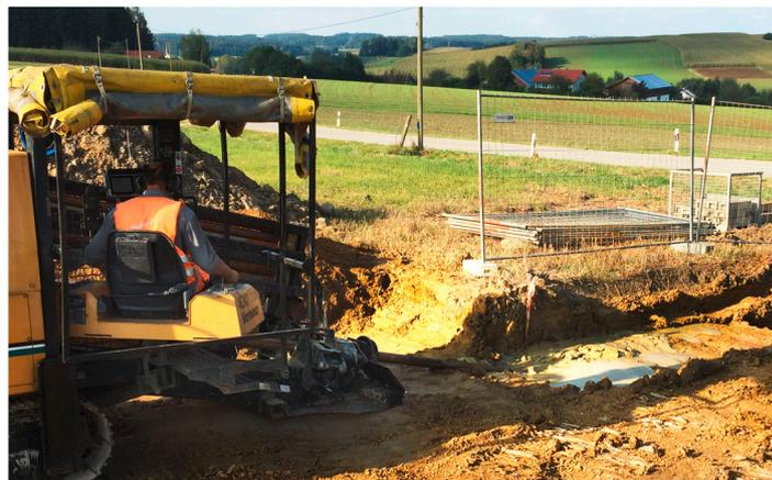
Die Bohrungen erreichen eine Länge von 45 bis 140 Metern und eine maximale Tiefe von sieben Metern.
