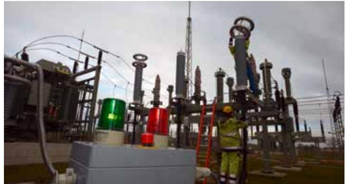
Über den Winter prüfen wir im Umspannwerk abschließend die Hochspannungs-Schaltanlagen. Die Inbetriebnahme und die Anbindung an das regionale Verteilernetz sind im Frühjahr 2017 geplant.
