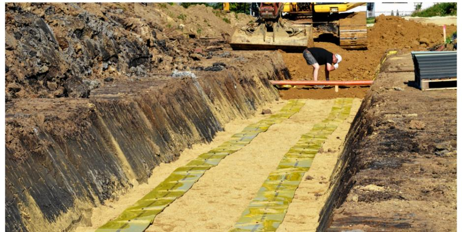
Sobald die Rohre verlegt sind, werden sie eingesandet. Kabelschutzplatten dienen als Warnung, falls dort zu einem späteren Zeitpunkt gegraben wird.
