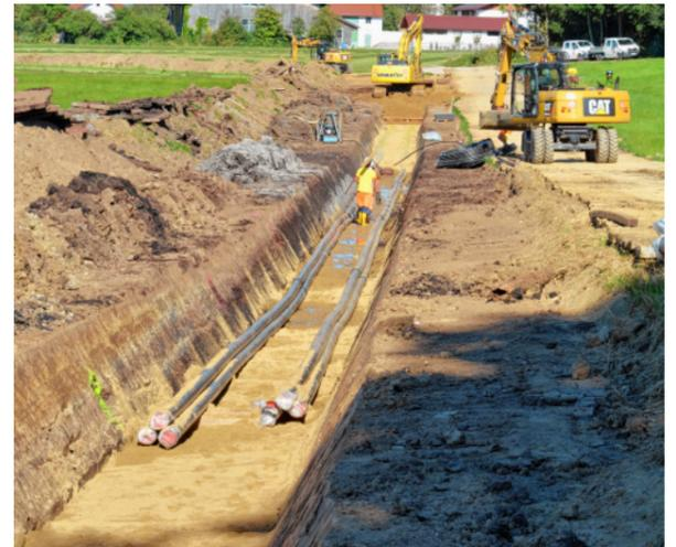
Sobald die Rohre im Graben verlegt sind, werden sie eingesandet.
