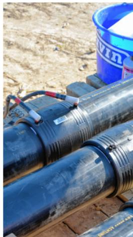
Die Rohre werden elektrisch verschweißt.
