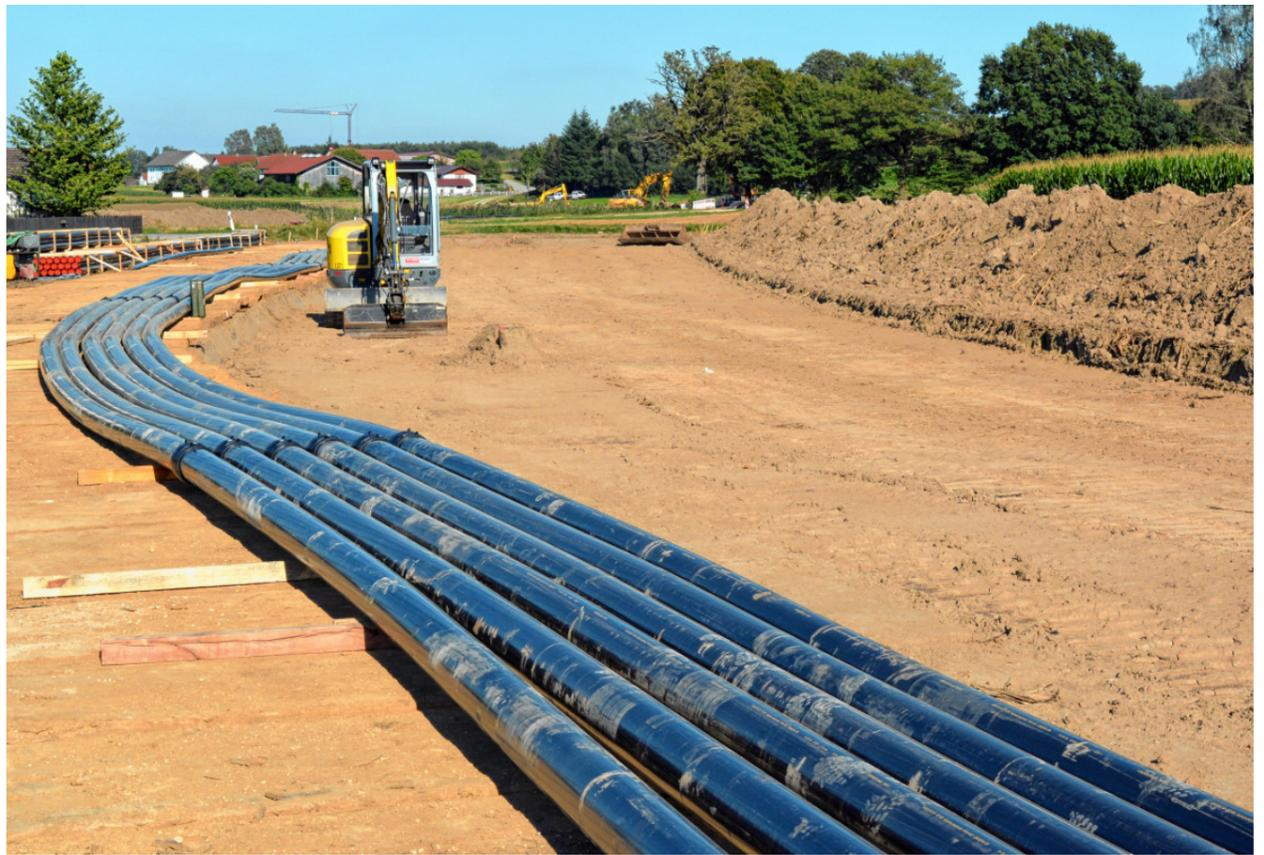
Parallel zum Graben werden die Rohre ausgelegt und später in den Graben gehoben.
