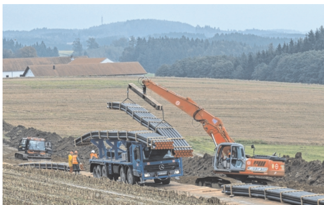
Langsam arbeitet sich die Wanderbaustelle vor: Mit einem Bagger werden die Rohre entlang der Stromtrasse ausgelegt und dann in den Gräben verlegt.
