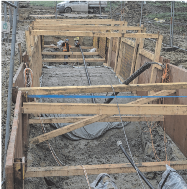
In der Muffengrube werden die Kabel eingezogen und dann aufwendig miteinander verbunden.
