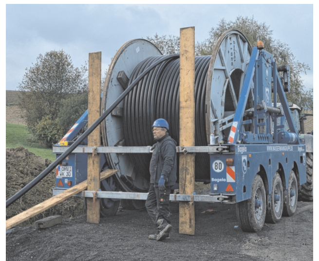
Bis zu sieben Tonnen schwer sind die bis zu einem Kilometer langen Kabel.
