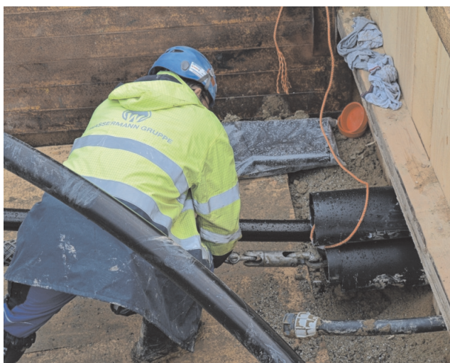
Langsam und gleichmäßig verschwindet das Kabel im Rohr und wird zum nächsten Muffenstandort gezogen.
