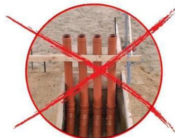
**Bild 1 - freizuhaltende Bedien- und Arbeitsfläche für Versorgungseinrichtungen**
