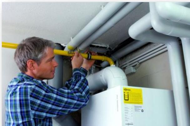
Gut befestigt und durch Farbe vor Korrosion geschützt. So hält diese Erdgasleitung auch in feuchter Umgebung lange. Lösungsmittel können Kunststoffleitungen schädigen. Deshalb sind Farbanstriche bei Kunststoffleitungen nicht erlaubt.
