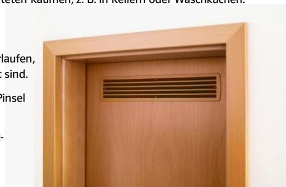
Lüftungsöffnungen in Rohrverkleidungen durchlüften den Hohlraum, in dem Erdgasleitungen verlegt sind und verhindern Dauerfeuchtigkeit. Lüftungsöffnungen in Türen oder Fenstern des Aufstellraumes Ihres Erdgasgerätes sorgen für eine ausreichende Verbrennungsluftversorgung bei raumluftabhängigen Erdgasgeräten.
